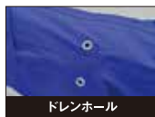
ドレンホール
